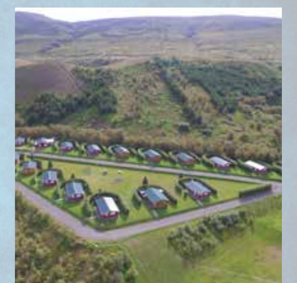
Orlofshúsabyggingin að Illugastöðum en þar á FMA 2 hús.
