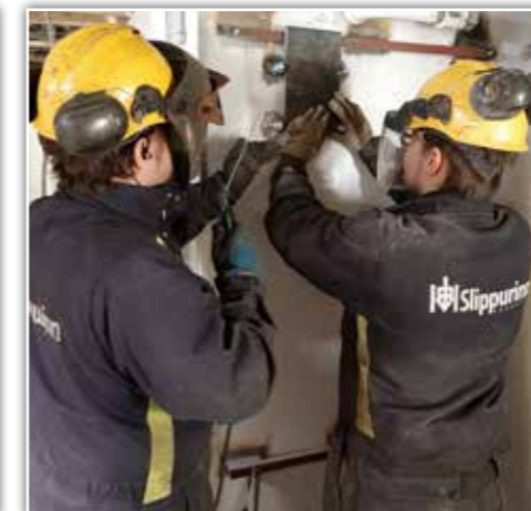
Freyr Þórðarson og Maciej Morawski, stálsmiðir hjá Slippnum, sjóða plötu á vegg um borð í Frosta frá Grenivík.
